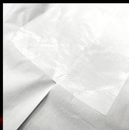
養生シートのつなぎに
